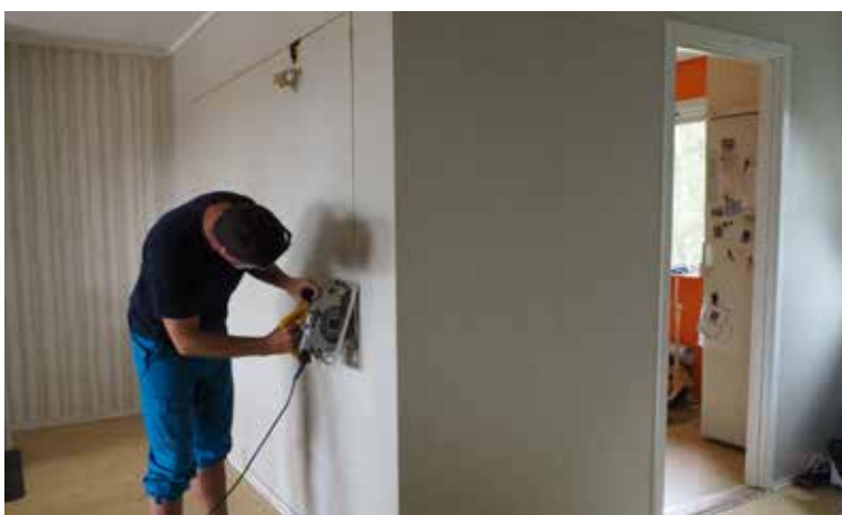
HULL I VEGGEN: Drømmen har alltid vært en åpen løsning, men skilleveggen mellom kjøkken og stue er en såkalt kassett der rød og ledninger ligger skjult. Løsningen ble å halvveis åpne vegg mellom kjøkken og stue og la kassetten stå.
