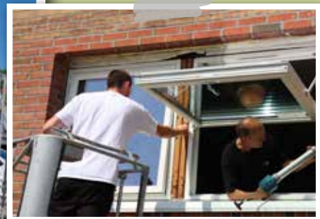
Leif Punnerud og Marius Christensen bytter vinduer i Hovland borettslag.
