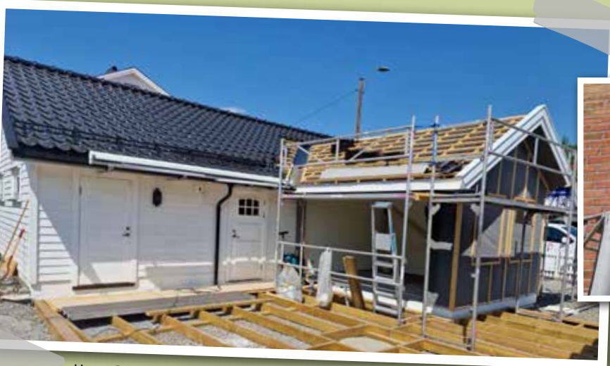
Her er Boservice i arbeid på en enebolig og garasje i Stavern.
