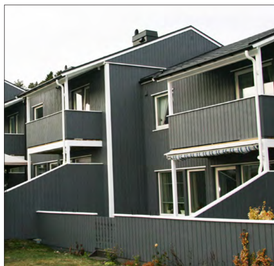
Tagtvedt er et av de største rehabiliteringsprosjektene til LABO
