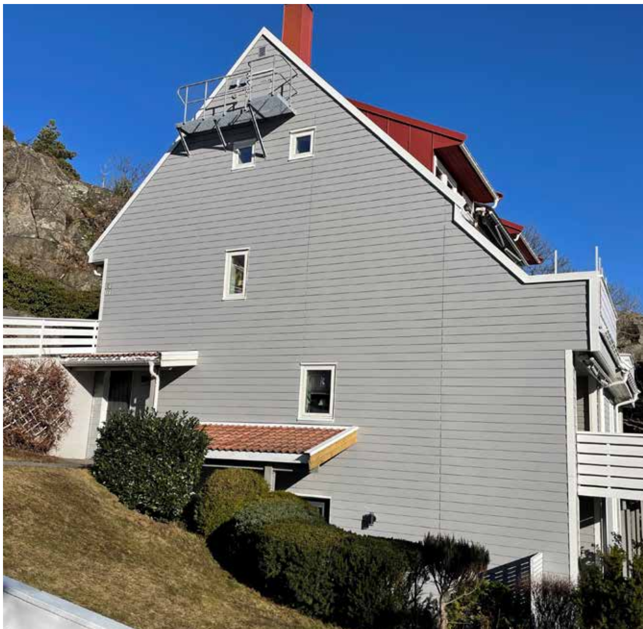
Rehabilitering av fasade Ohlselia.
