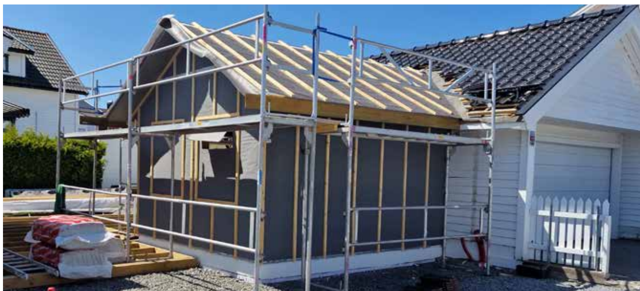
Boservice gjennomførte rehabilitering av enebolig i Stavern.
