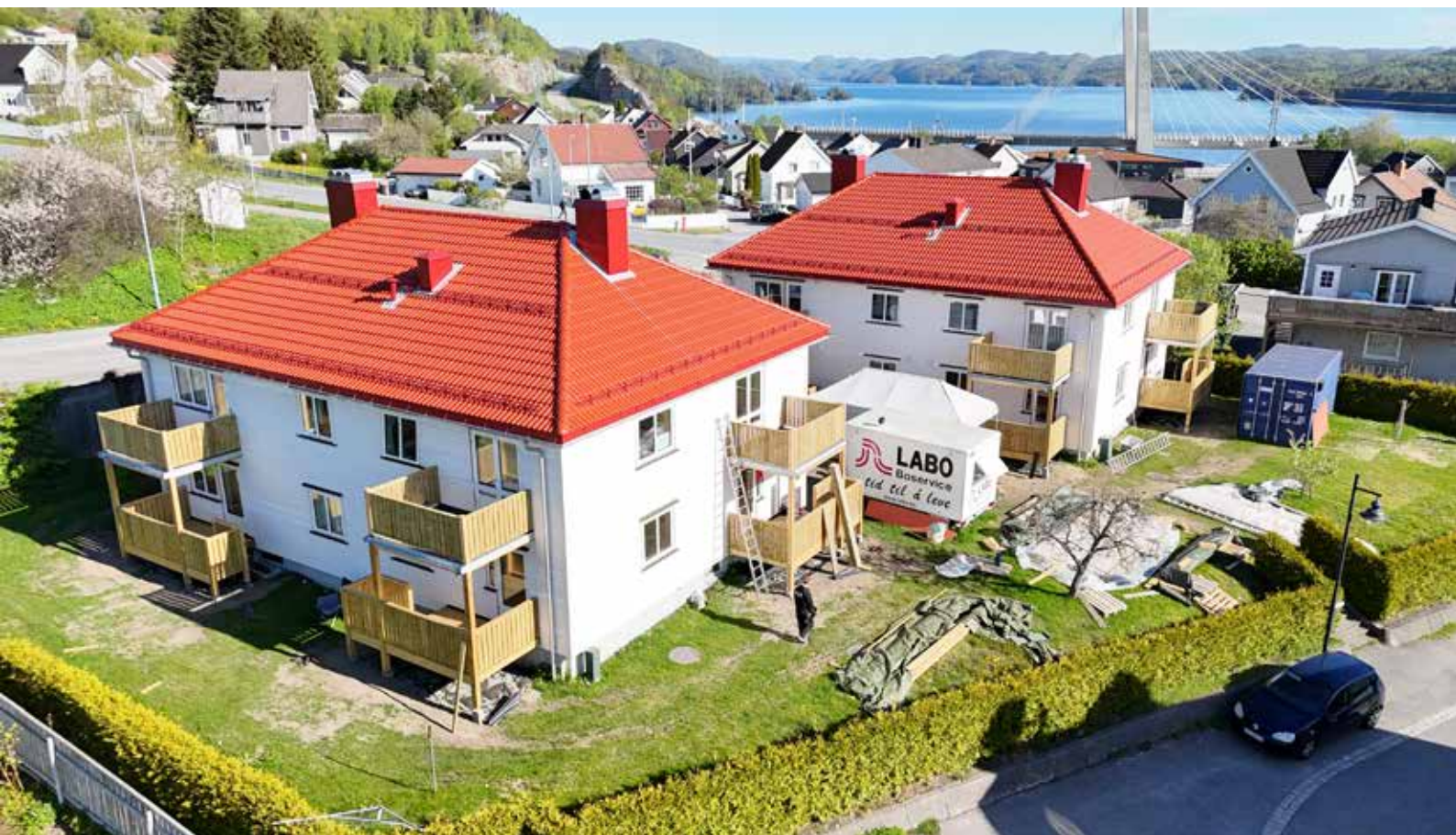
Dronebilde fra Josef Minde borettslag som har byttet tak, vinduer og kledning.
